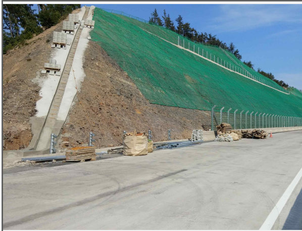
① 절토사면 시공 현황(시점 횡단)
