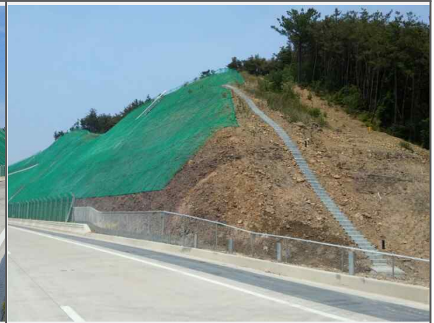
② 절토사면 시공 현황(중점 횡단)
